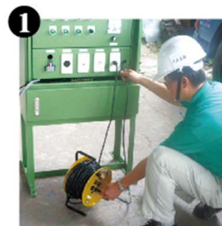
1. 接上電源並將模擬負載線接入被測延長線
